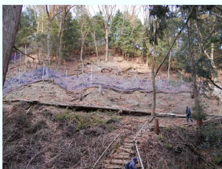
獣害防止ネットの設置状況
